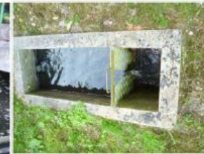
Canal de sortie
